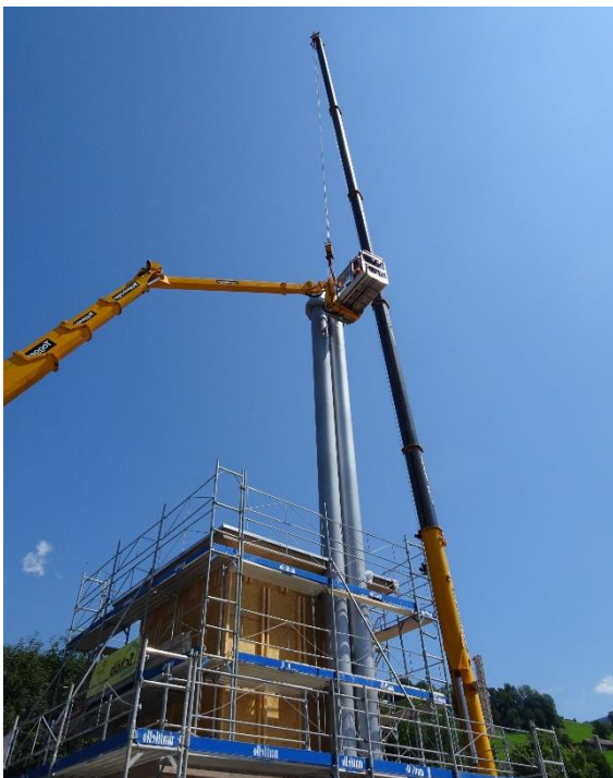
Montage der Kamine beim Speichergebäude der neuen Holzschnittelheizung
