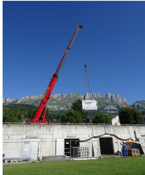
Anlieferung des tonnenschweren Heizkessels der neuen Holzsnitzelheizanlage
