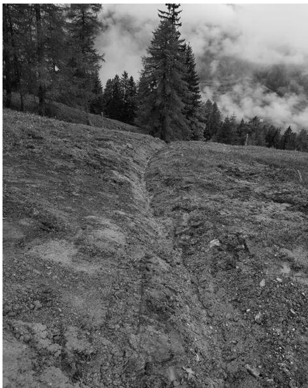
Instandstellen Entwässerungsgräben auf Alp Fanülla
