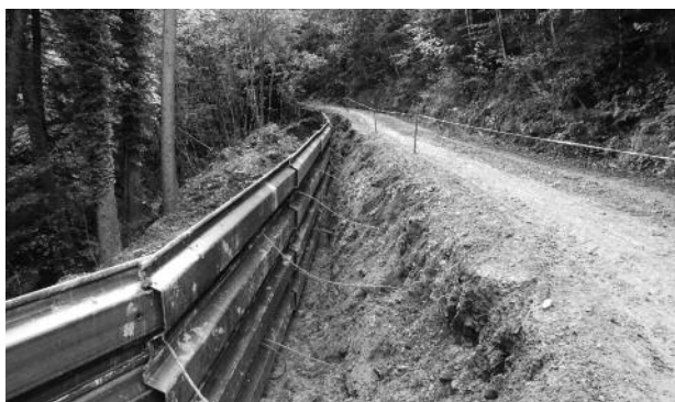
Sanierung durch Einbau einer Pfahlwand
