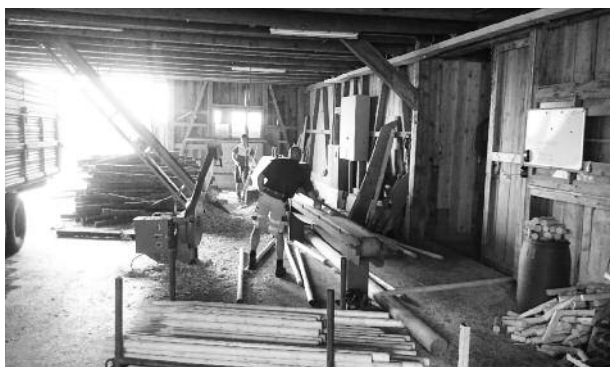
Pfahlproduktion beim Werkhof Hültsch
