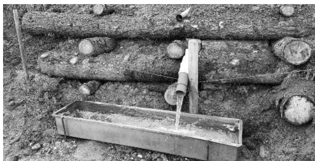
Sanierter Tränkeplatz auf Alp Fanülla
