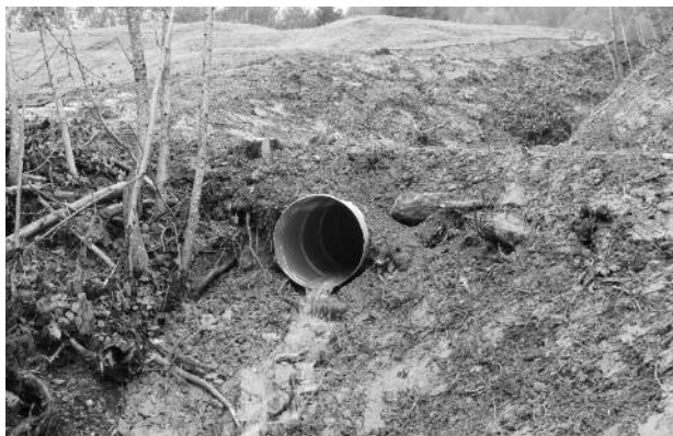
Sanierter Bachdurchlass Fadura
