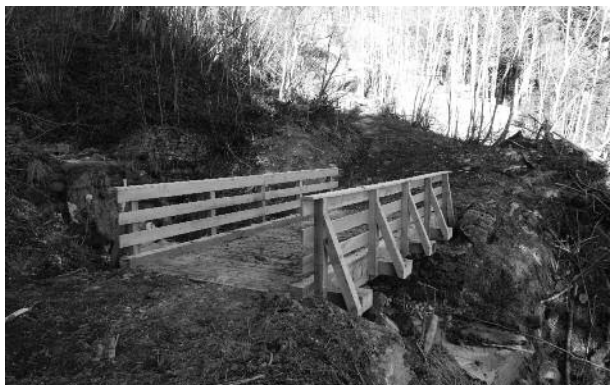
Neue Brücke beim Schaftriebweg Lenz-Fadura
