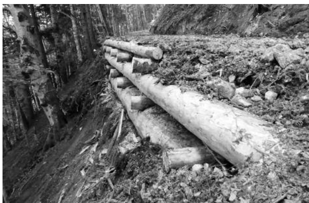
Sicherung der Zufahrt Abendweid (im Bereich Gempeler) durch Einbau von Holzkästen
