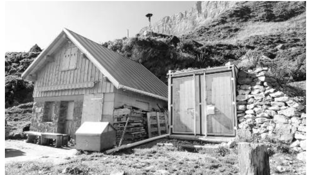
Sanierte Sässhütte mit Materialcontainer, Einfach im Ausbau, aber dem Zweck entsprechend
