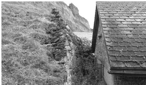
Lawinenschutzmauer vor der Sanierung
