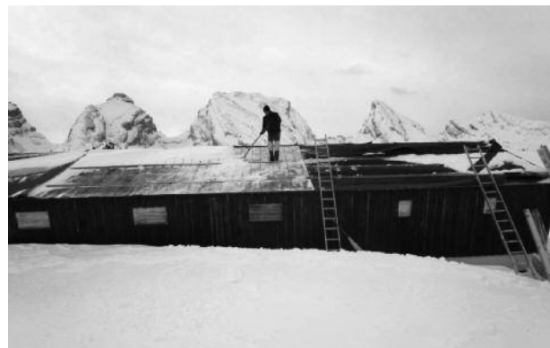
Reparaturarbeiten am Schopf Thurtalerstofel, Sellamatt
