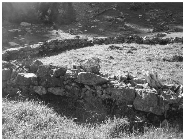
Steinmauer im Gazolf, seinerzeit als Einfriedung genutzt für die Lagerung von Bergheu
