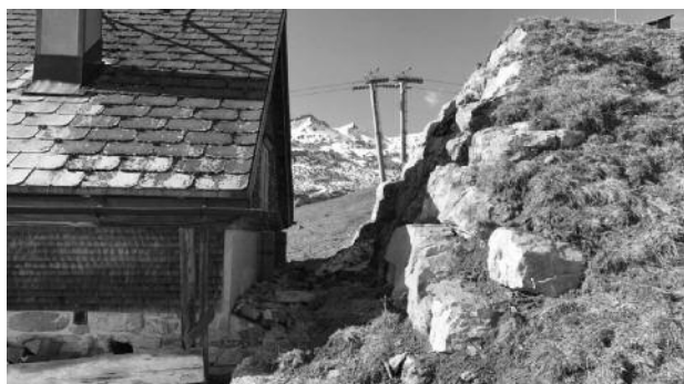
Lawinenschutzmauer nach der Sanierung
