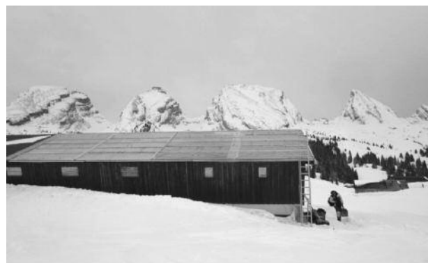
Notdach, welches den notwendigen Schutz für das Alpgebäude bis zum Frühjahr bietet
