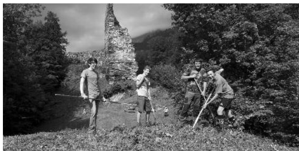
Helfer bei den Unterhaltsarbeiten auf Ruine Hohensax
