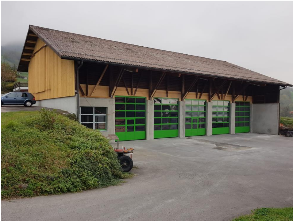
Ansicht Werkhof Hültsch nach Umbau und Sanierung
