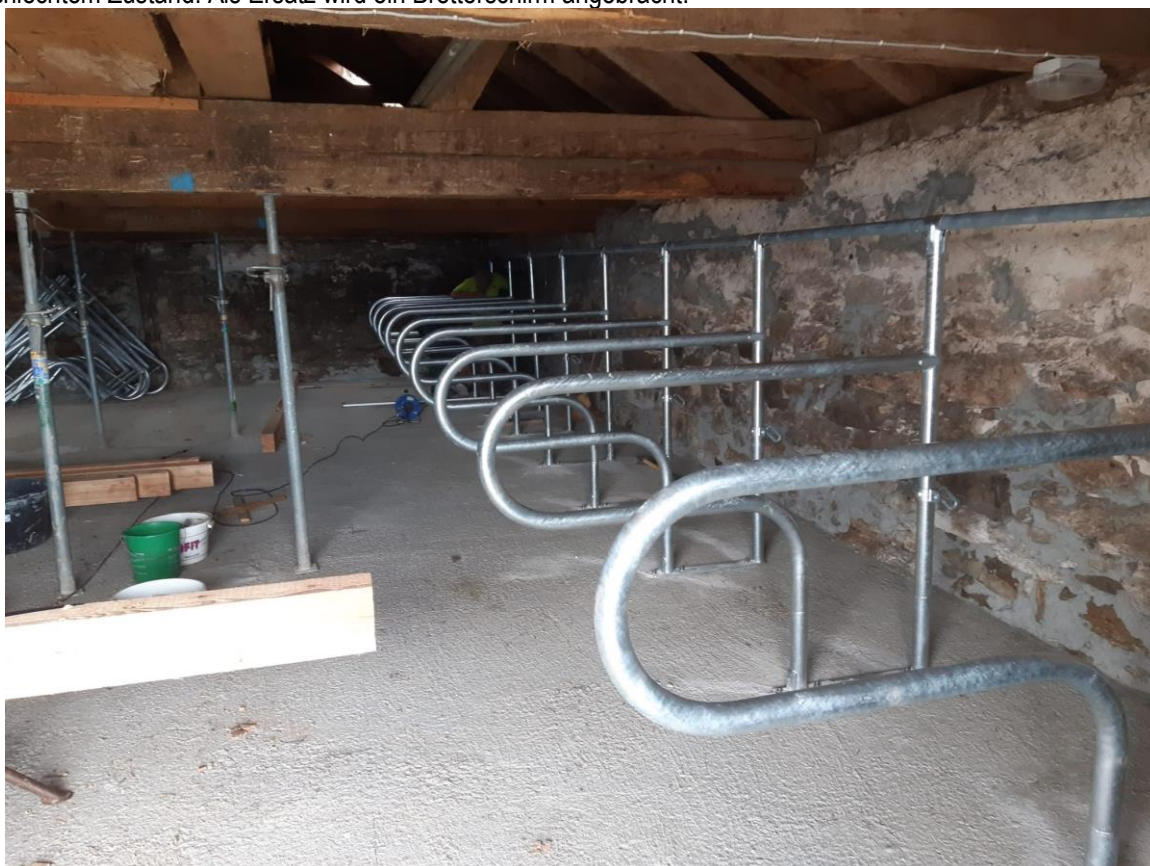
Umgebauter Innenbereich mit neuen Liegeboxen im bestehenden Viehschopf
