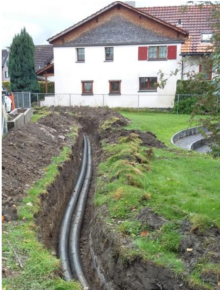
Erweiterung der Fernwärmeleitung Underfelsbach / Neufeld ab Schulhaus Hof
