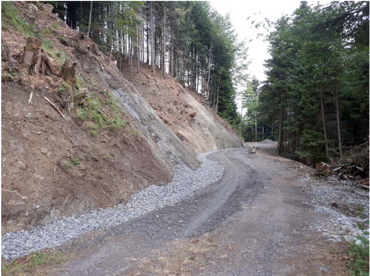
Sanierte Rutschung, Teilstück Holderbödeli
