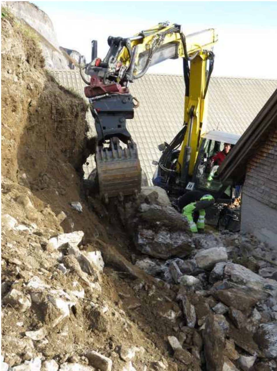
Sanierung Lawinenschutz Alphütte Naraus
