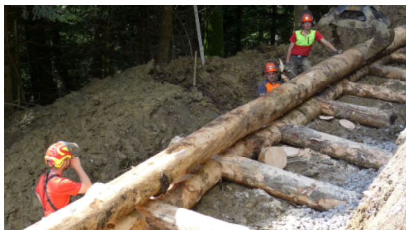
Einbau eines Holzkastens im Bereich Fadura - Chnebelbrugg Ortsgemeinde Gams
