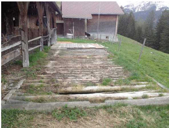
Abdeckung Düngerlager vorher
