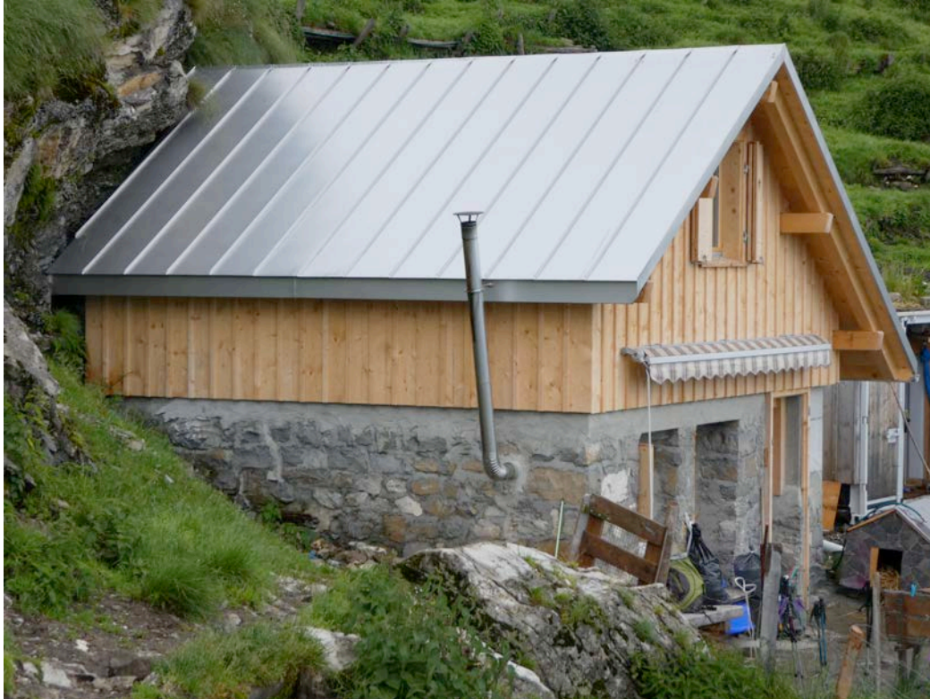
Die Sanierte Sässhütte wurde im Innenausbau, schlicht dem Verwendungszweck eingerichtet
