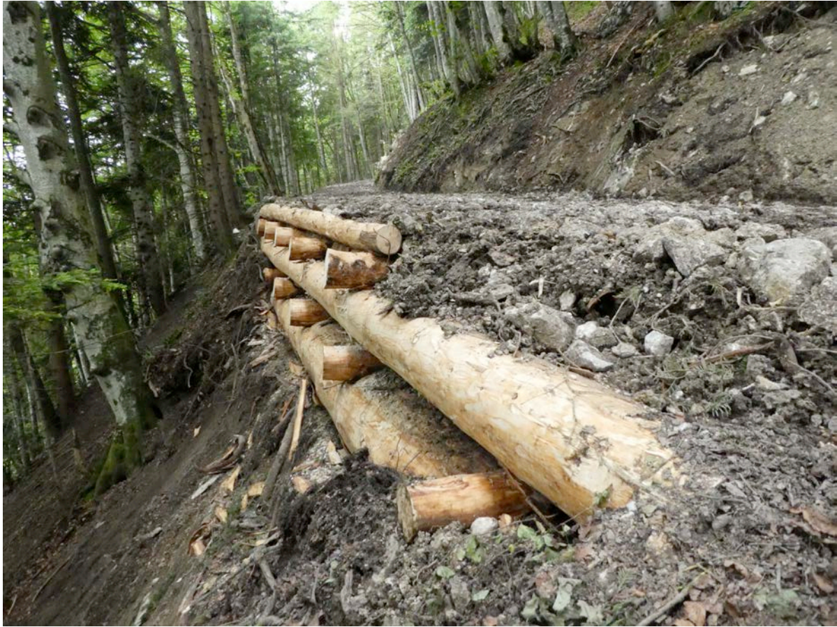
Sicherung des Alpweges Zufahrt Abendweid mit Einbau eines Holzkastens
